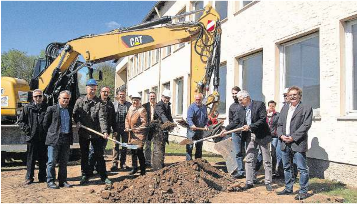
Den obligatorischen Spatenstich für das Mehrgenerationenhaus in Saltendorf vollzogen u.a. Bürgermeisterin Maria Steger (Mitte), Kämmerer Georg Beer, Gebäudeplaner und Architekt Alfred Popp, Tiefbaustadtbaumeisterin Sabine Eichinger, Bauleiter Reinhard Gürtler und Hochbaustadtbaumeister Karlheinz Weiniger sowie Vertreter der am Bau beteiligten Firmen. Foto: Artmann
