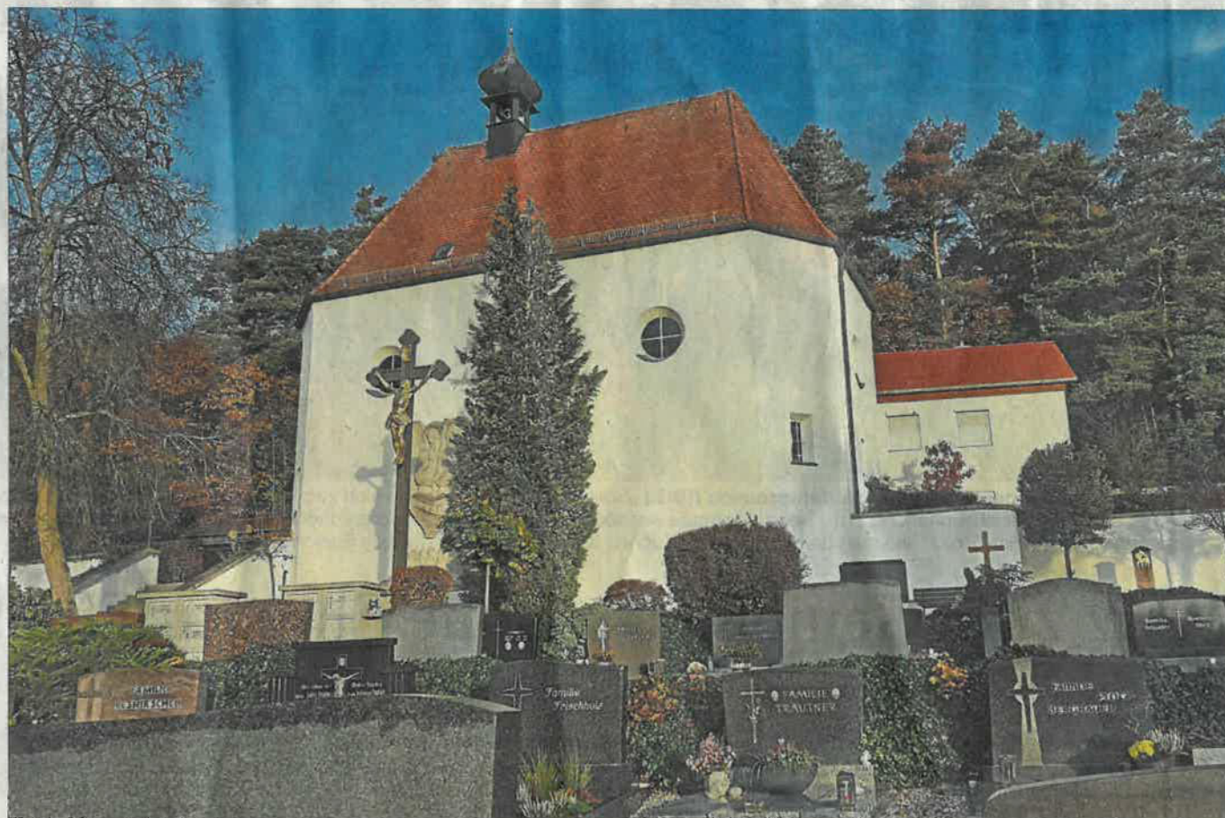
Das Gebäude am Friedhof ist nicht mehr zeitgemäß, so der Tenor. 550 000 Euro soll die Baumaßnahme voraussichtlich kosten. Foto: Schmid
