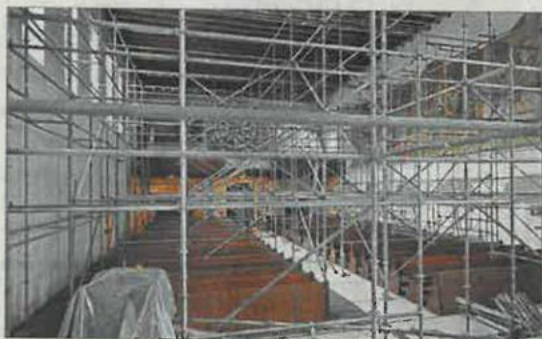
Während der Bauphase war ein Gerüst bis zur Decke erforderlich.
