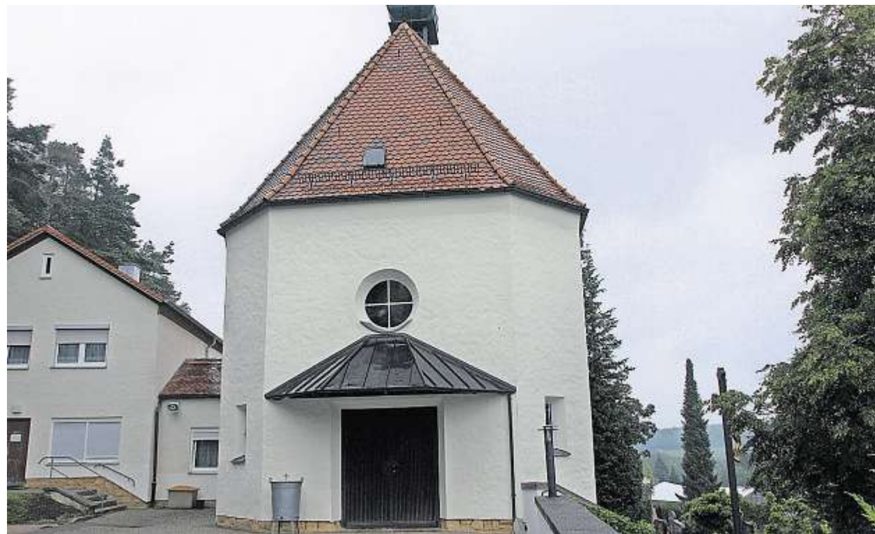
Die Trauerhalle aus der Zeit der Alt-Wackersdorf-Umsiedlung ist in die Jahre gekommen und wird nächstes Jahr saniert.
