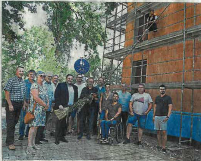
Im Beisein vieler Ehrengäste erfolgte durch den Zimmerer Sebastian Haberl (auf dem Gerüst stehend) der Richtspruch für den Anbau an das Teublitzer Verwaltungsgebäude. Foto: Werner Artmann
