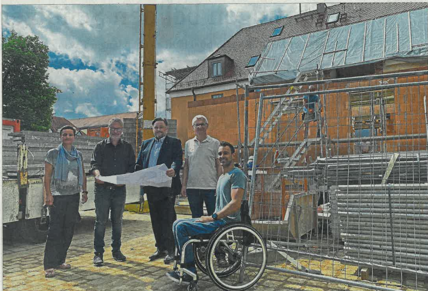
Die Baustelle „Teublitzer Rathausanbau“ besichtigten kürzlich Bauamtsleiterin Sabine Eichinger, Architekt Alfred Popp, Bürgermeister Thomas Beer, Bauleiter Josef Spichtinger und Hochbauleiter Jochen Oswald (v. l.). Foto: Werner Artmann
